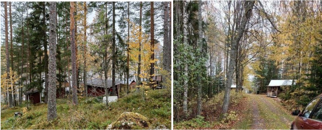
Samman tilan alueella sijaitsevan RA/1-tontin rakennuksia (vas.) ja alueelle johtava Souruntie (oik.).
