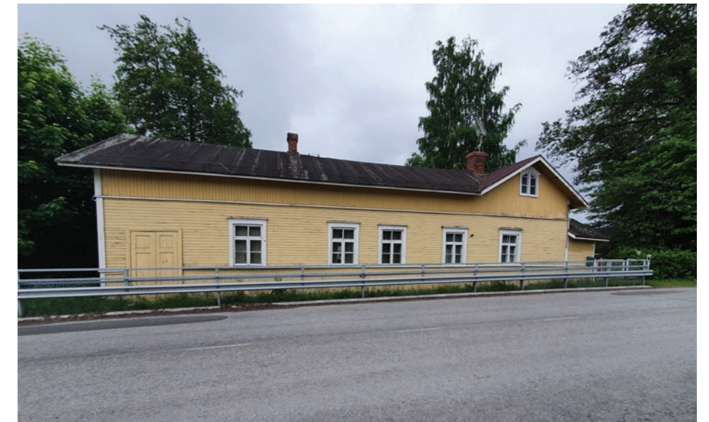
2. "Aaltolan" asemakaavassa suojelluksi merkitty rakennus.
